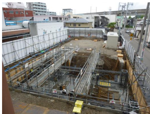
↑中1生の教室から見える工事現場の様子
