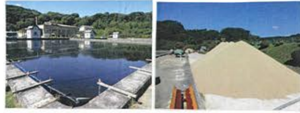
↑ 緩速沈殿池 ↑ ろ過砂
